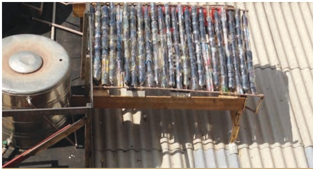
Painel solar em teste na obra Mundi MBigucci
